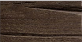
..... V - verwittert / lackiert
